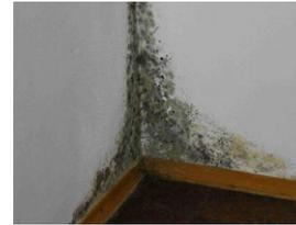
**Бактерии** (грибок, плесень). Изначально поражение поверхности бактериями проявляется визуально в виде пятен, которые трудно отмыть или переокрасить. Опасность кроется в том, что бактерии очень быстро размножаются, и таким образом в короткие сроки способны полностью испортить внешний вид покрытия. Также бактерии постепенно уничтожают ЛКП, снижая его прочность и долговечность. Напомним, что во влажной среде риск поражения поверхности бактериями гораздо выше.
