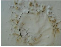
**Влага.** Вода проникает в стены снаружи и конденсируется внутри от разницы температур. Таким образом, она постепенно накапливается в любом материале. Дождь, снег и конденсат – все это разрушает стены и покрытия. Влага в первую очередь скапливается между ЛКП и подложкой,
