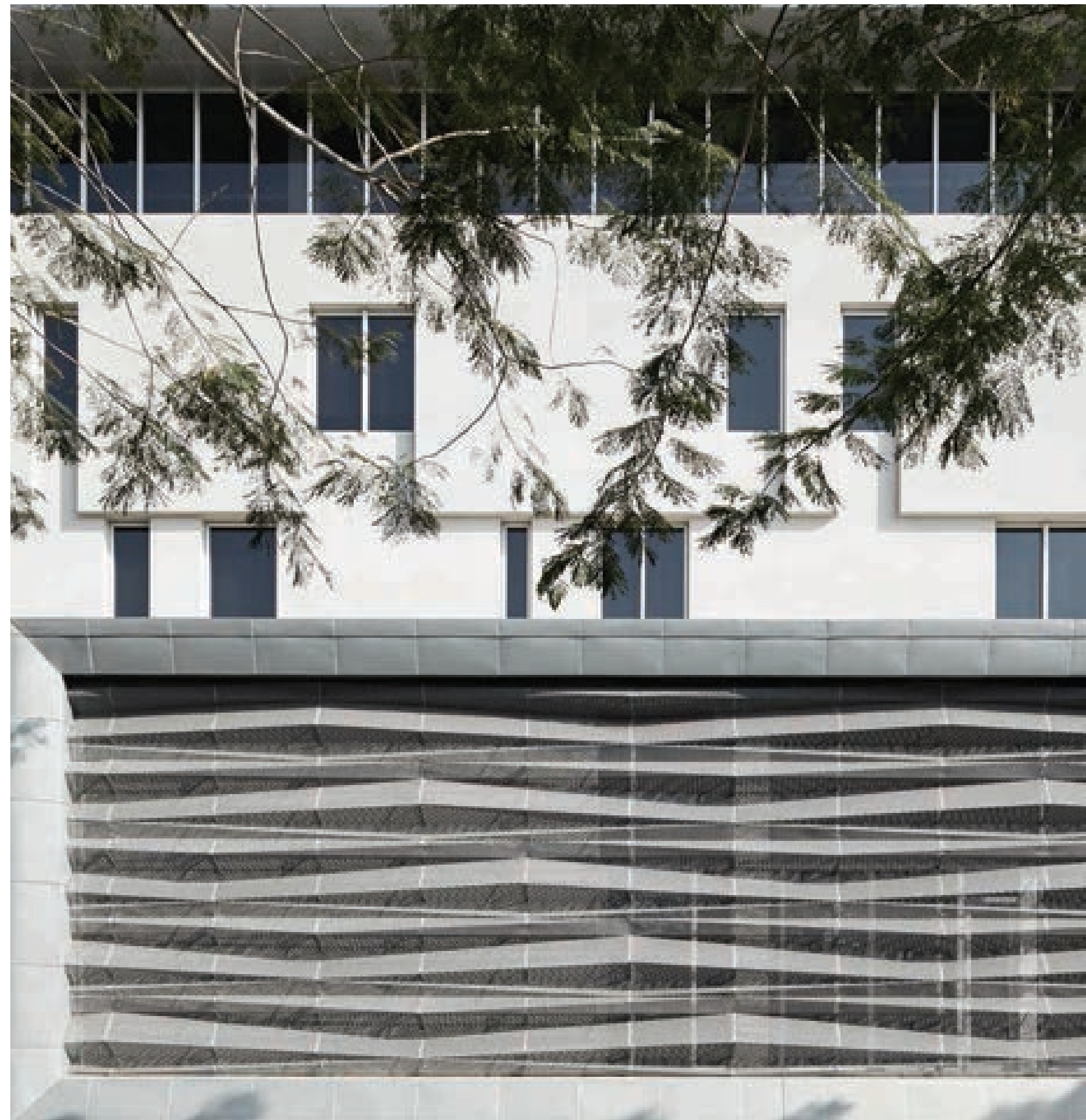
RMIT, академическое здание в Хошимине, Вьетнам. Добавлен текстурный слой с системой проветривания фасада.
